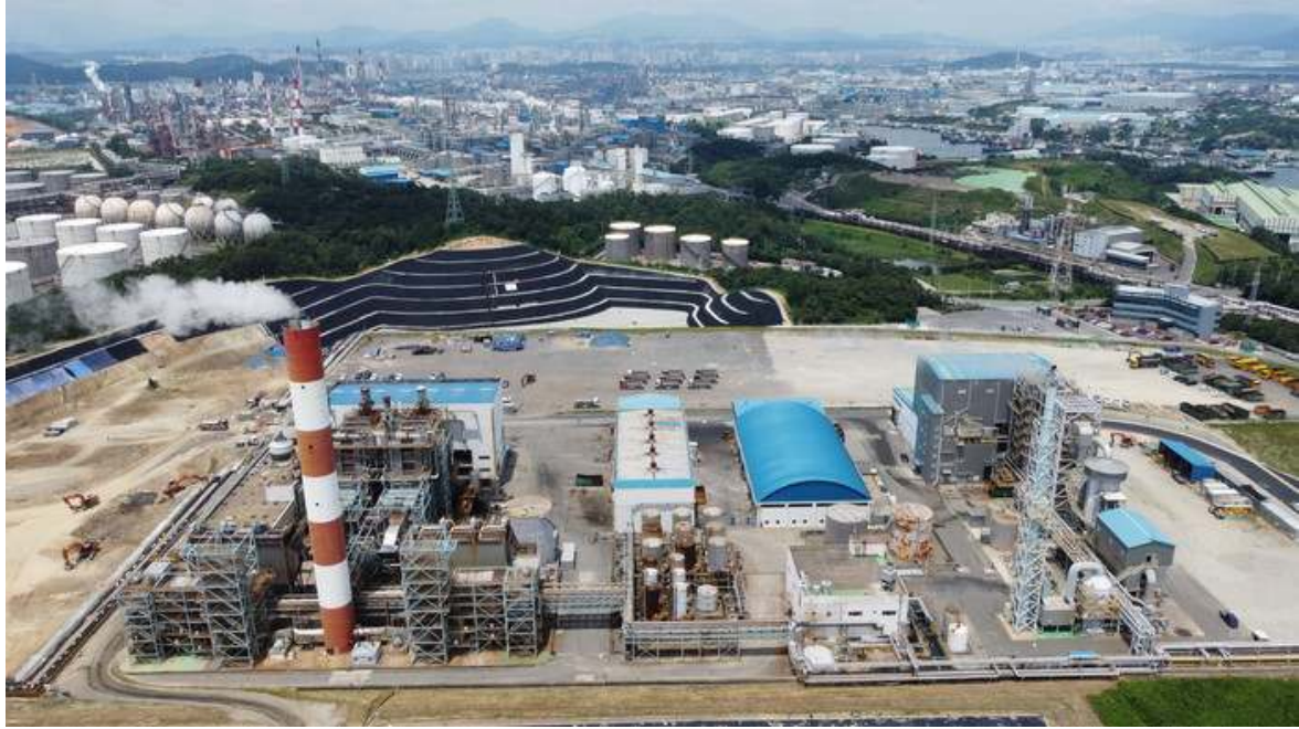
▲ 소각전문시설 (주)코엔텍 전경
