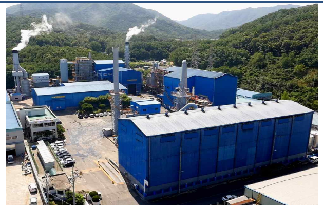
◆소각시설 사업장 사진 출처 : 한국자원순환에너지공제조합
